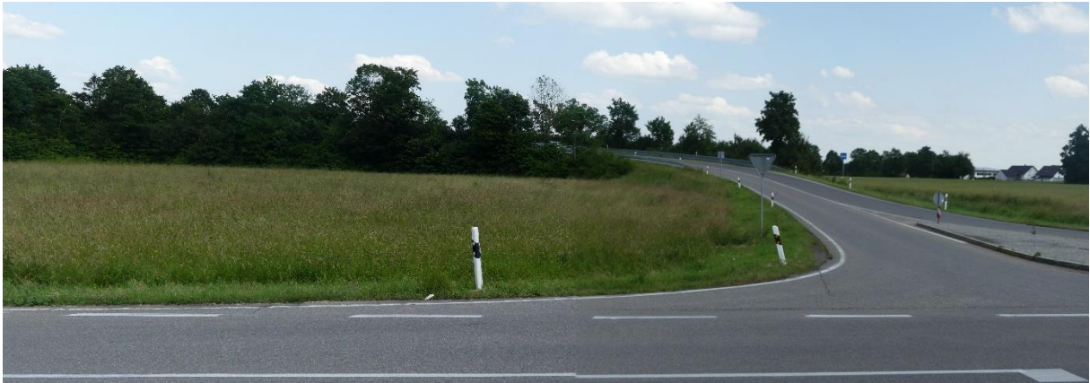
Abbildung 13: Blick von West nach Ost über den GB2 und die Auffahrtsschleife von der L260 zur B312
