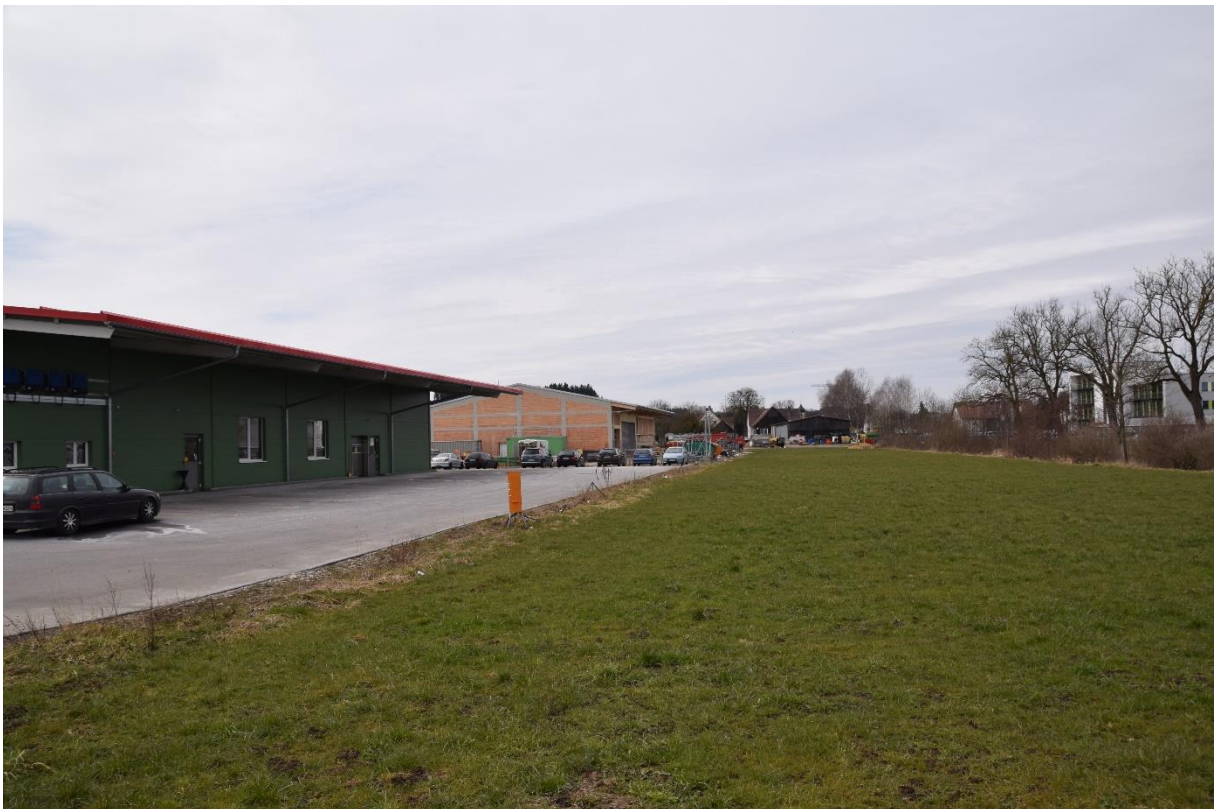
Abbildung 3: Blick auf Fl.-Nr. 1836 und die angrenzende Gewerbefläche der 1. Änderung BP Brühlwiesen
